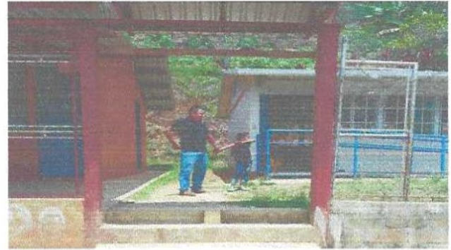
Foto 2: Se observa la entrada de la Escuela donde se instalará un Portón.
