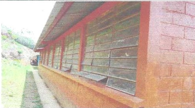
Foto 3: Se observa las ventanas donde se cambiarán los vidrios.
