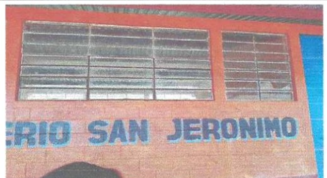
Foto 4: Se observa las ventanas donde se instalarán balcones.
